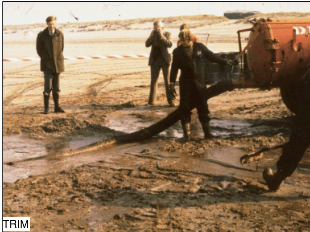
Gierwagen zuigt de olie uit een kuil
