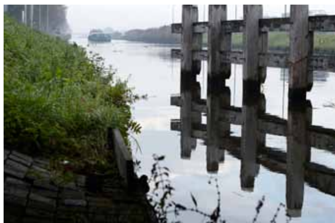
Het kanaal vanaf de Dungense Brug
