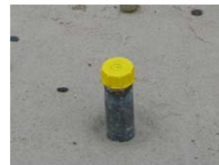
Ontluchting In de buizen zitten gaatjes en bovenop een ontluftingsdop.
