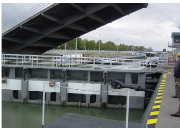
Figuur 4.5 Buitenhoofd Oostsluis met verkeersbrug
