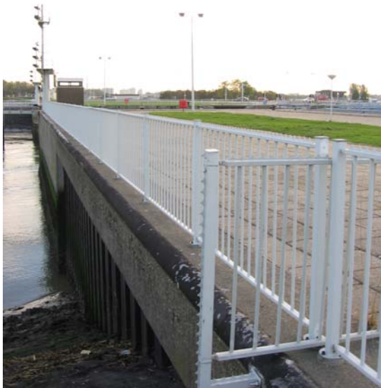
Figuur 4.2: Sluisterrein Westsluis met bestaande leuningwerk
