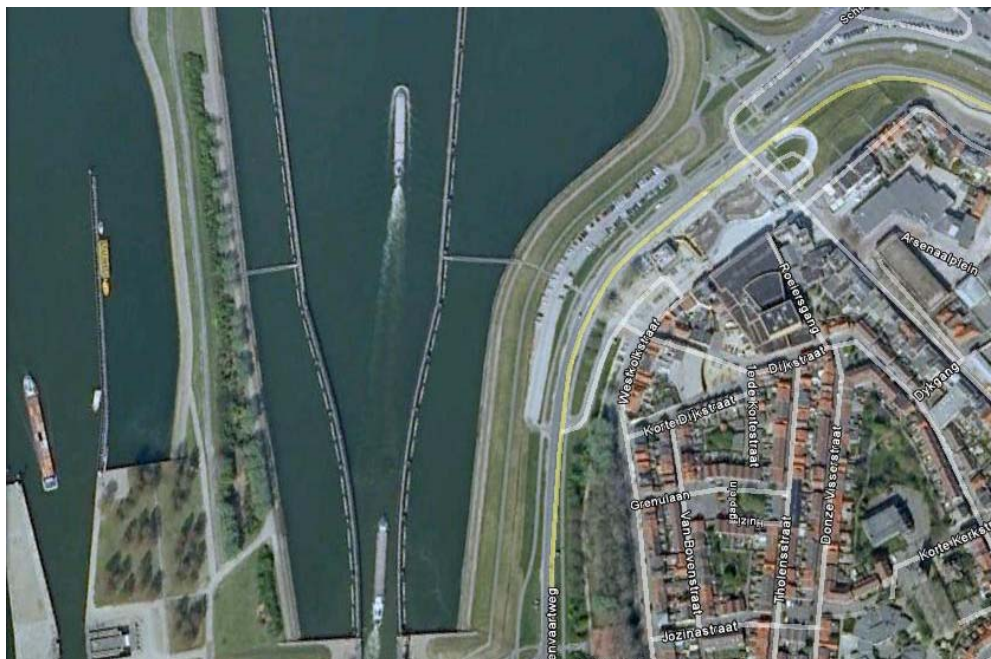
Figuur 4.3 Situatie Oosthavendijk
