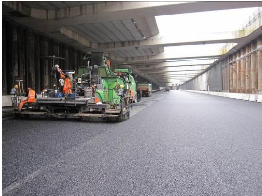
Foto: asfalteren toerit verdiepte ligging
