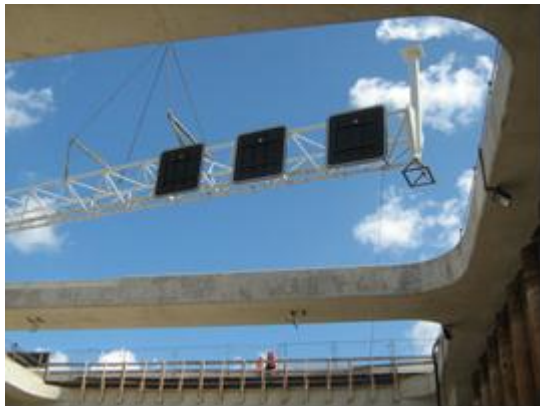
Foto: plaatsen verkeerssignalering verdiepte ligging
