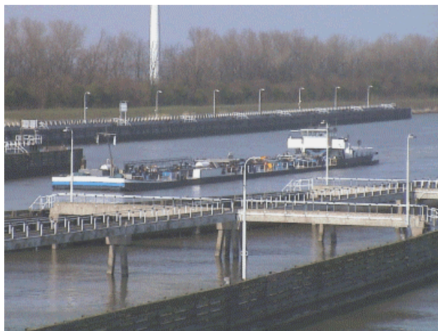
Figuur 29.1 Sluizen spelen een belangrijke rol in de registratie van over het water vervoerde chemische stoffen.
