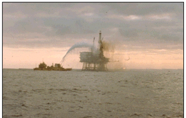
Figuur 17.7 Explosiegevaar bij een ongecontroleerde spuitsprayer op een platform
