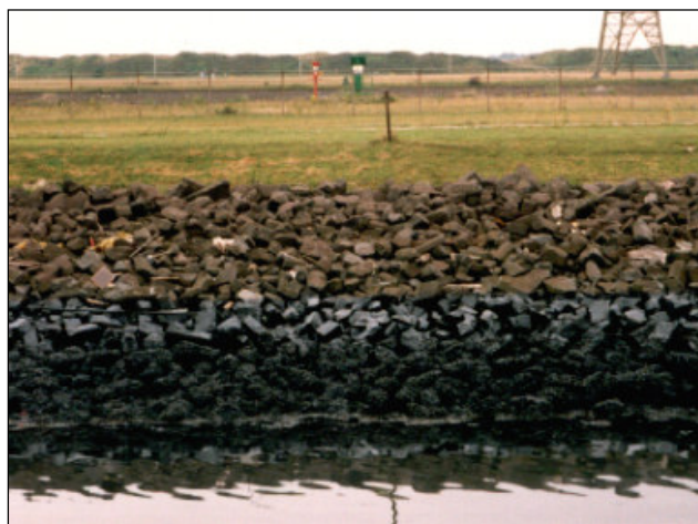
Figuur 14.6 Olie tussen basaltblokken is moeilijk te verwijderen.
