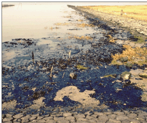
Figuur 14.9 Glooiingen kunnen met name in getijwater, tijdens ebperiode door hun schuine afloop behoorlijke hoeveelheden olie vasthouden.
