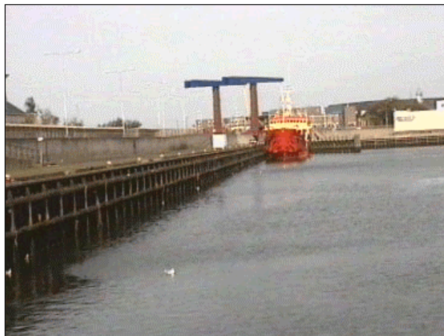
Figuur 14.3 Damwand kades zijn vaak gemakkelijk te reinigen
