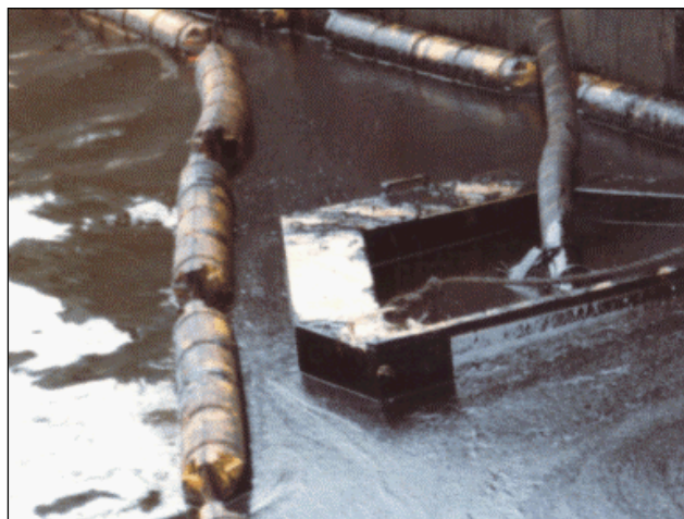
Figuur 14.8 Met behulp van een skimmer en een oliekerend scherm kan op stilstaand water de olie meestal goed worden opgeruimd
