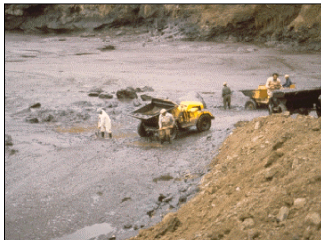
Figuur 10.6 De mechanische verwijdering van de bulk hoeveelheid olie dient altijd eerst plaats te vinden voordat men de restant olie biologisch kan laten afbreken
