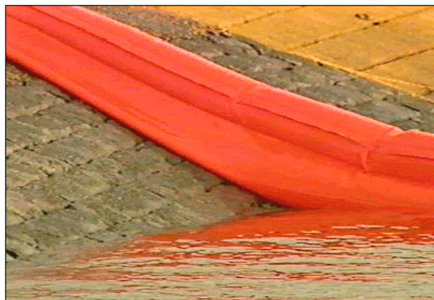
Figuur 5.5 Scherm speciaal geschikt voor de overgang van water naar oever
